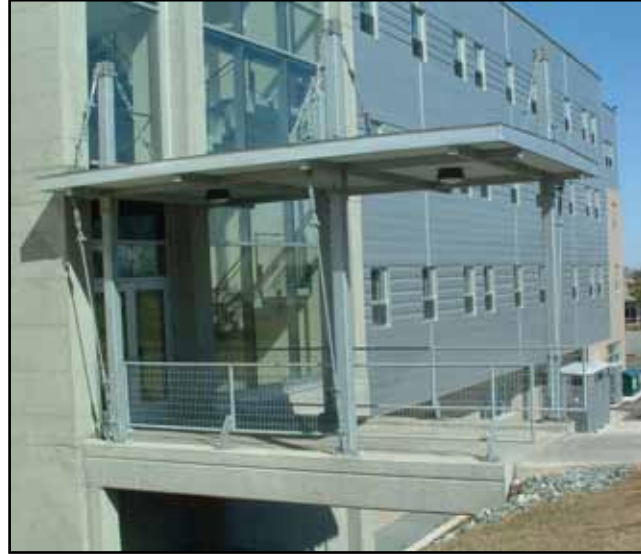
Figure 12.7: Université de Sherbrooke Pedestrian Bridge.
